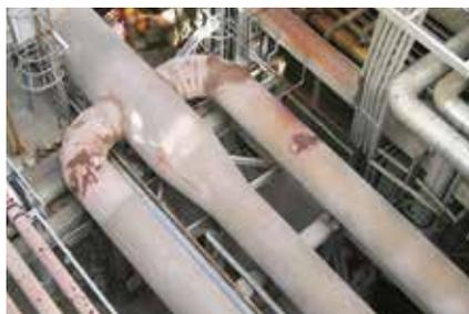
Image visible et image thermique d'une détérioration du revêtement réfractaire dans une conduite d'air.
