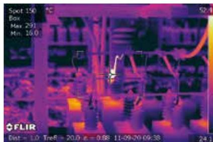
*Cette image thermique d'un condensateur à haute tension montre un point chaud dû à une mauvaise connexion.*
